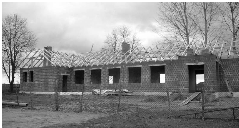
Na budowie szkoły w Kotwasicach
